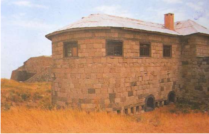
Resim 10: Kaponiyer (Caponier) yapısı örneklerinden Sivişli Tabyası Karargah binası. Caponier Fransızların kullandığı bir tahkimat örneğidir. Genellikle kuru hendeklerin içerisinde inşa edilir. Amacı, düşmanın hendeklerden, tahkimat içine geçmesini önlemektir. 61
